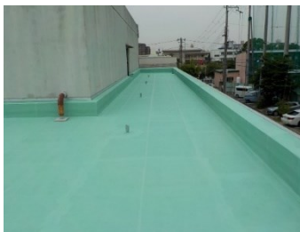
2階屋根(アスファルト防水) 前 ⇒ 後
