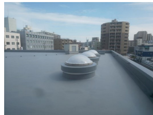
C棟(シート防水；機械式固定) 前 ⇒ 後
