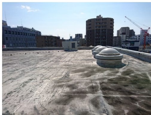
C棟(シート防水；機械式固定) 前 ⇒ 後
