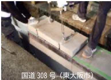
写真 3.3 小型ボックス活用埋設による整備
