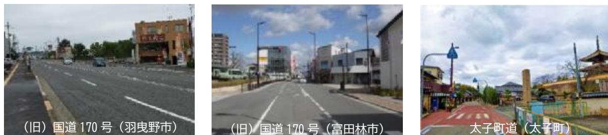
写真 2.3 都市景観に配慮した無電柱化
