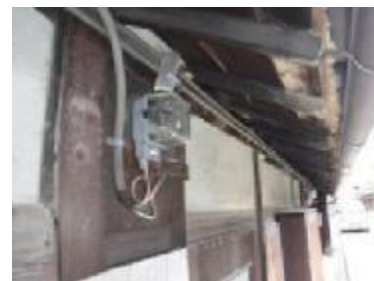
写真 5.3 軒下配線 整備事例 (富田林市 寺内町)
