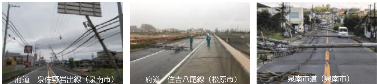
写真 2.1 平成 30 年 台風 21 号による電柱倒壊等による道路閉塞
