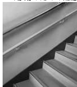
・ 手すりの設置
