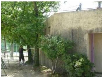
高圧洗浄機で外壁をきれいにしています
