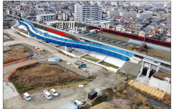
恩智川（法善寺）多目的遊水地（※③）柏原市
