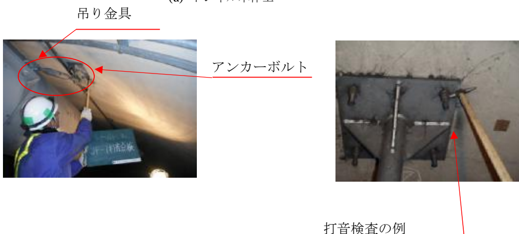
写真-解 6.2 打音検査作業状況
