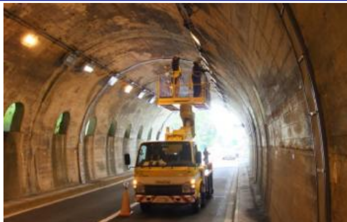
写真-解 6.1 近接目視作業状況
