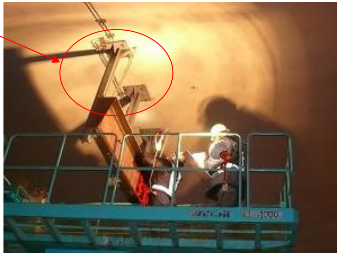
写真-解 6.3 触診作業状況
