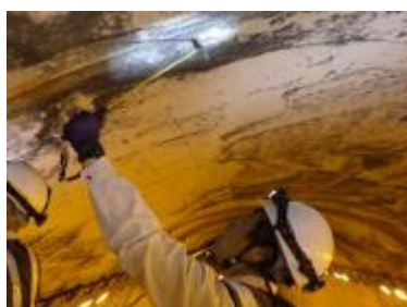
(a) トンネル本体工
