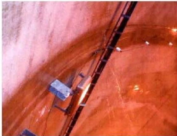
付写真-1.7 漏水（噴出）している例
