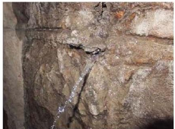
付写真-1.7 漏水（噴出）している例
