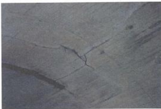
付写真-1.5 複数のひび割れで覆工コンクリートがブロック化している例
