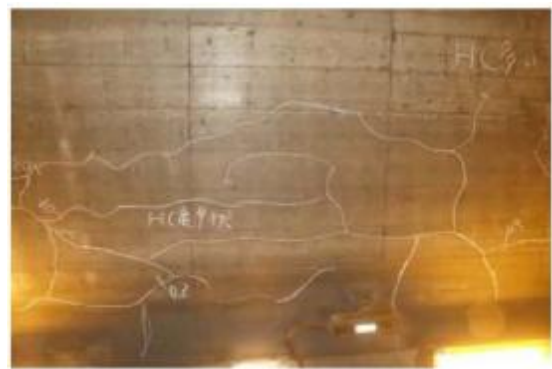
付写真-1.5 複数のひび割れで覆工コンクリートがブロック化している例
