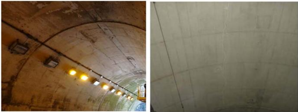
付図-1.4 覆工の天端とその付近に発生する変状の例
