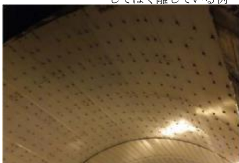
付写真-1.11 鋼板接着（左）・繊維シートの接着（右）例
