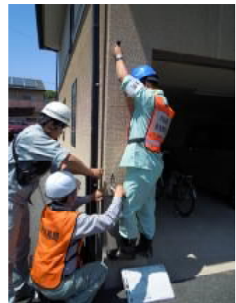
家屋被害認定（1次調査）の様子
