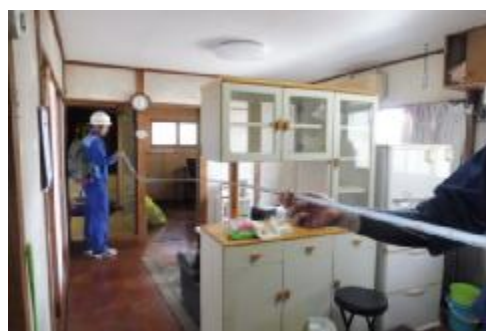
家屋被害認定〔2次調査（屋内）〕の様子
