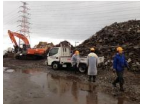
矢護川災害廃棄物仮置き場での作業の様子
