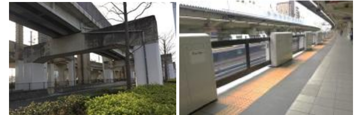
鉄道施設の耐震補強
