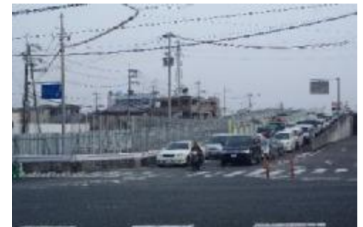
立体交差化事例(事業中) 府道茨木亀岡線 西河原西交差点(茨木市)
