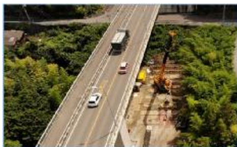
国道170号 (4車線化)
