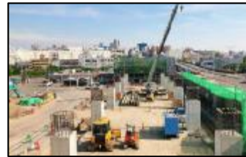
北大阪急行延伸 箕面萱野駅付近
