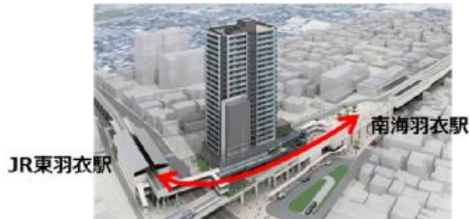
出典：羽衣駅前地区第一種市街地再開発事業（高石市） 連続立体交差事業と駅前の再開発事業の組合せにより、乗継連絡通路を整備（R1.8完成）
