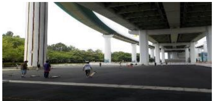
りんくう公園 スケートボード広場 (完成)
