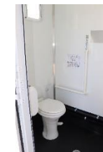
山梨県北杜市 トイレトレーラーの内部 （同市HPより）
