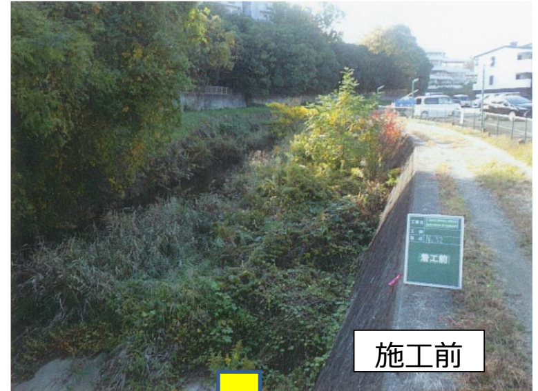
勝尾寺川河道掘削 （箕面市域）
