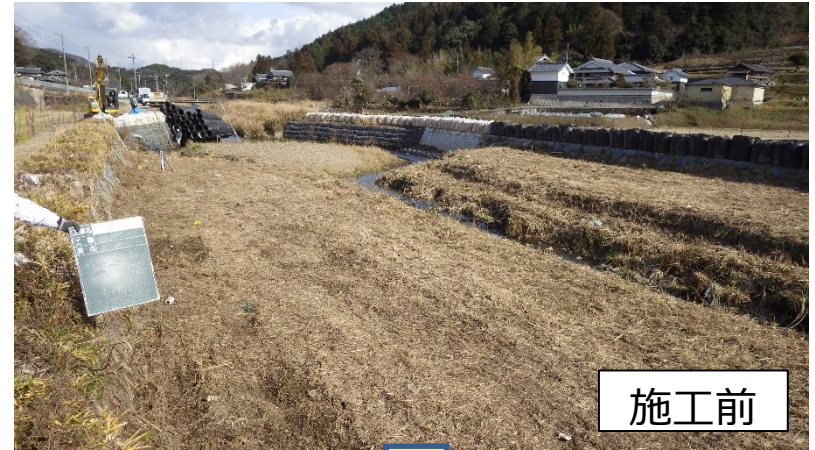
田尻川改修 (能勢町域)
