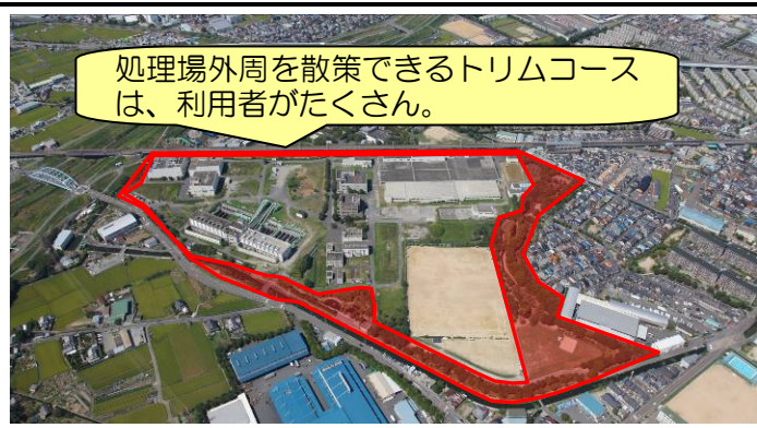
高槻水みらいセンター（赤色部分が周辺緑地）
