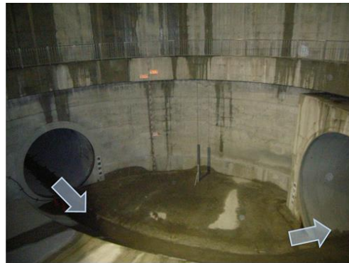
地下河川への接続例(寝屋川南部地下河川若江立坑) 左が下水道増補幹線、右が地下河川 (大阪府河川室ホームページより)
